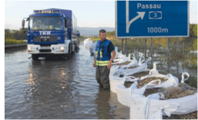
Abb. 63: Improvisiertes Behältersystem mit Industriesäcken (THW)
