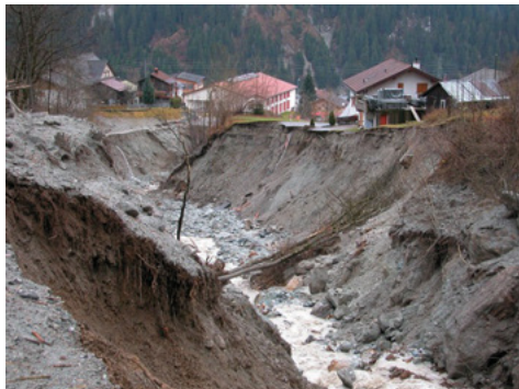
Abb. 9: Seiten- und Tiefenerosion in Rueun GR (PLANAT)
