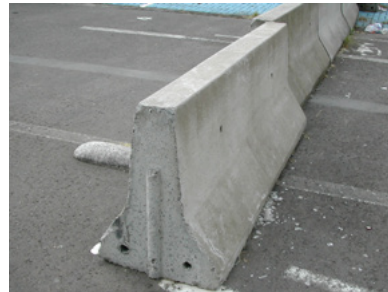
Abb. 65: Elemente mobiler Betonschutzwände (Wikipedia)
