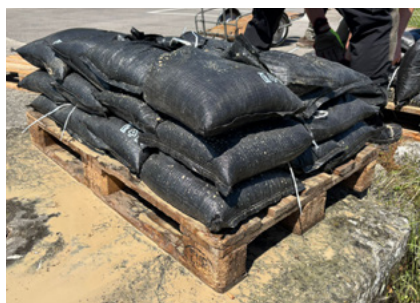
Abb. 52: Sandsäcke auf Europaletten bereitstellen (THW & BABS)
