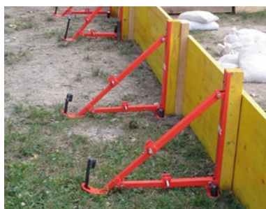
Sicherung mit verstellbaren Abschalböcken aus dem Bausektor
