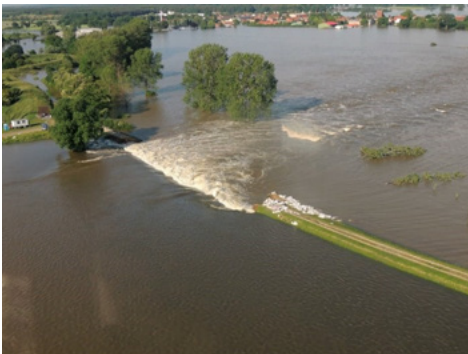
Abb. 68: Deichbruch (Robert Jüpner, Technische Universität Kaiserslautern)
