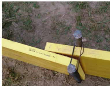
Sicherung der Armierungseisen mit Drilldraht
