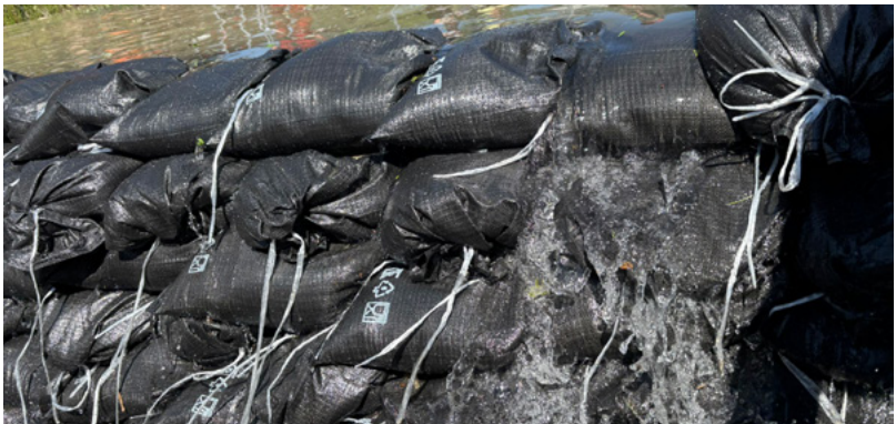
Abb. 41: Überströmter Sandsackdamm (BABS)
