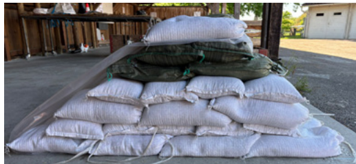
Abb. 47: Aufbau eines Regeldamms (BABS)
