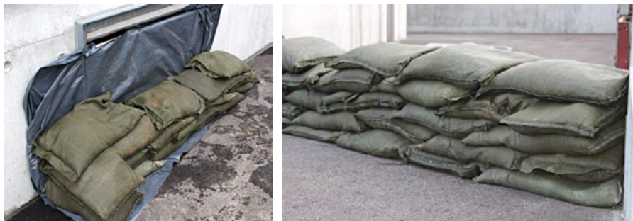
Abb. 50: Beispiele einfacher Sandsackmauern (BABS)
