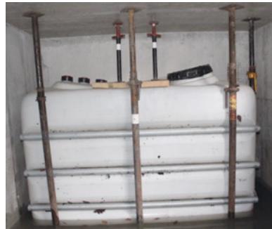
Abb. 83: Sicherung eines Heizöltanks (Gebäudeversicherung Bern GVB)
